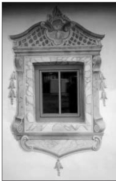
Lüftlmalerei an den Fenstern des Kratzerbäcks
