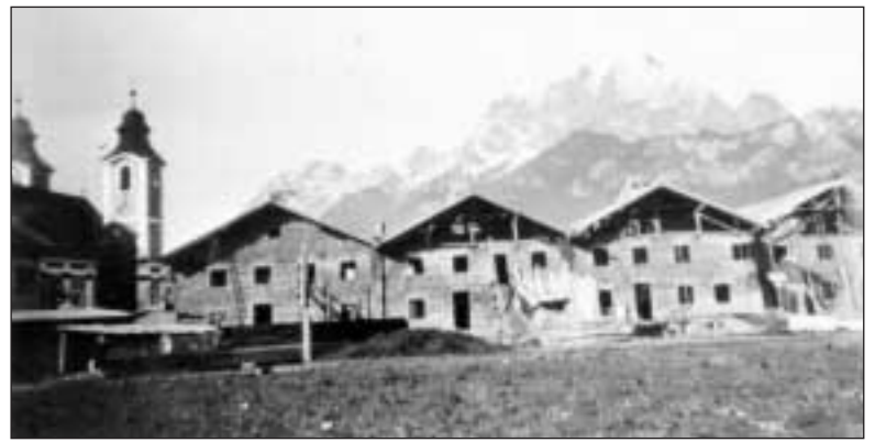
Südtirolersiedlung St. Johann in Tirol, im Bau 1940 (Archiv Ing. Josef Wörgötter)
